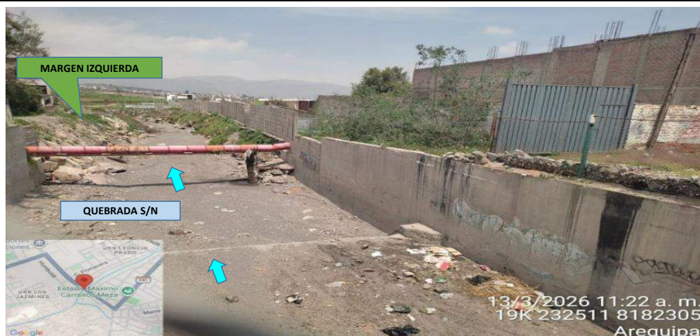
IMAGEN 01: SE OBSERVA EN EL TRAMO DE LA QUEBRADA S/N, QUE SE ENCUENTRA SIN PROTECCIÓN EN LA MARGEN IZQUIERDA DESDE EL TUBO TRANSVERSAL, Y TAMBIEN SE OBSERVA VIVIENDAS CERCANAS AL CAUCE, Y EL CAUCE SE ENCUENTRA COLMATADO DE SEDIMENTOS.
