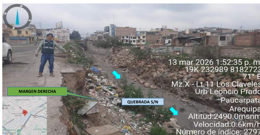
IMAGEN 02: EN ESTE TRAMO SE OBSERVA EN LA MARGEN DERECHA DE LA QUEBRADA S/N, SE ENCUENTRA SIN PROTECCIÓN SOCAVADA SU TALUD, Y EN LA MARGEN IZQUIERDA SE OBSERVA ROCA COLOCADA SIN PROTECCIÓN EN
